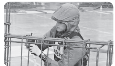
▲ハッカーと呼ばれる工具で鉄筋を結束・組み立てていく
