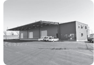
▲完成した第3保管庫
