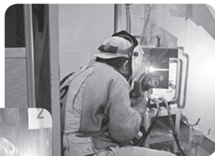
▼アーク溶接部門
