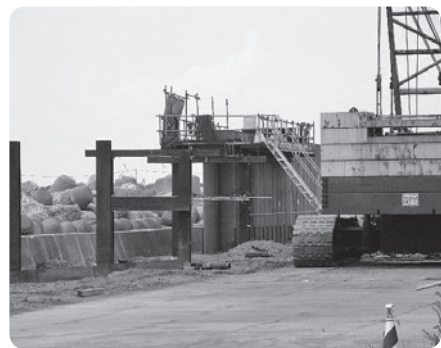
▲防災土木工事が進む石巻市の防潮堤工事を視察調査
