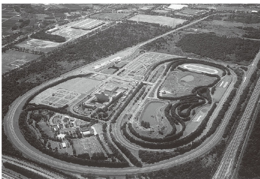
安全運転中央研修所全景
