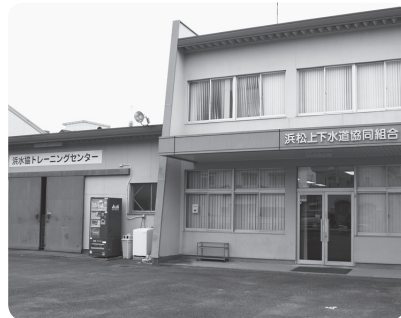
▲トレーニングセンター(左)と組合会館
