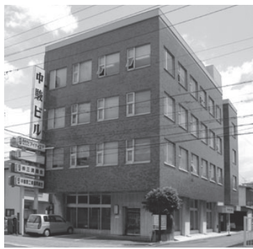
▲昭和44年竣工の「中駿ビル」。毎朝、職員総出で行うラジオ体操を、玄関の尊徳像がやさしく見つめる
