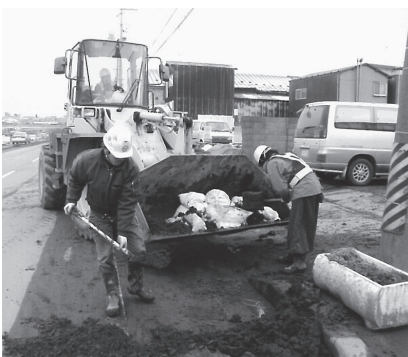
▲幹線道路確保のための復旧工事の様子（八戸市内）
