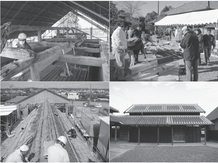
▼茅の葺き替えや傷んだ部材の取替えを行う組合員(写真左上、左下)。見違えるように修復された米蔵(同右下)。見学会で熱心に説明する組合員(同右上)
